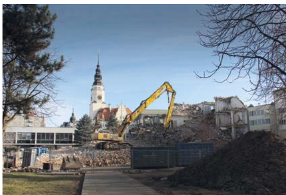
Demolice věžáku ministerstva zemědělství Foto Tomáš Skalík
